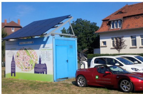
„Energiebox“ zur Speicherung regenerativer Energie in Helmstedt zur Speisung von Elektrofahrzeugen mit Hilfe einer Schnellladesäule.
