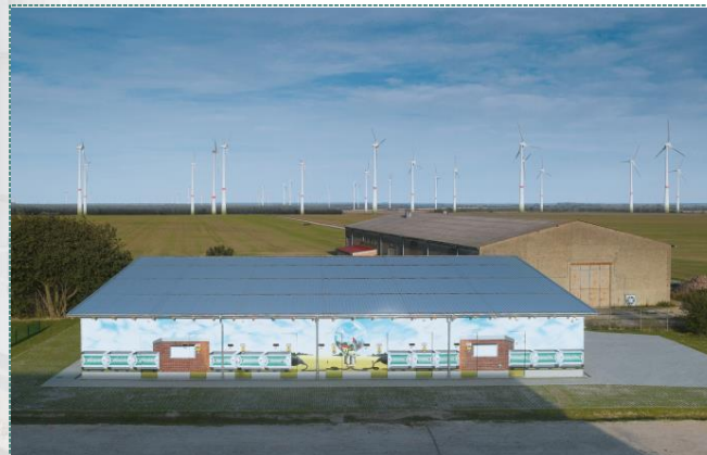
DAS RRKW FELDHEIM GRENZT AN EINEN ENERCON WINDPARK
