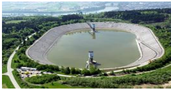
Waldshut: 176 MW, 0,4 GWh
