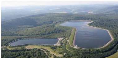
Waldeck II: 480 MW, 3,4 GWh
