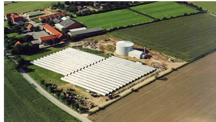
Rise 4 000 m 2 / 2,8 MW Solarer Deckungsanteil 45% mit Pufferspeicher, kombiniert mit Holzpellet-Kessel
