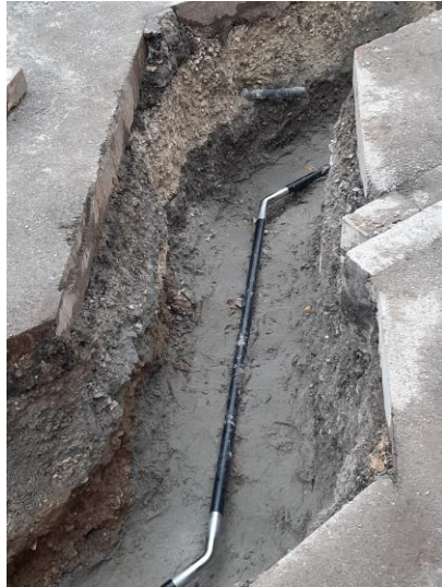
Verlegung im Sandbett
